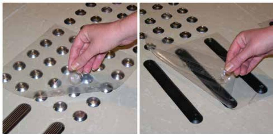
Elementos táteis pré-gabaritados de alerta com ou sem capa de aço inoxidável ABNT 304. Após a cura do adesivo o gabarito temporário de PVC deve ser removido e disposto para reciclagem.
