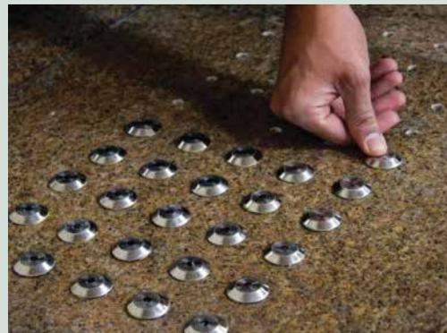
A instalação do piso tátil elemento pinado pode ser realizada de forma manual, com furação feita de forma individual ou por uma equipe da Mover Acessibilidade altamente treinada utilizando equipamentos homologados, garantindo maior agilidade e segurança.
